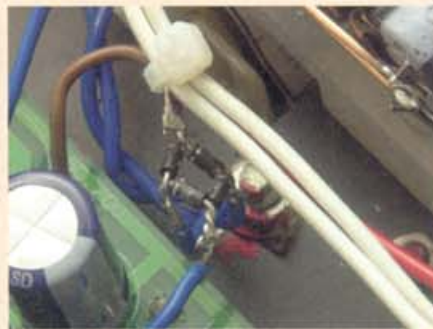
Nicht besonders schön, aber funktionell: die Gleichrichterbrücke nach dem Einbau. Der eine oder andere Kabelbinder sorgt dafür, dass das Konstrukt nirgends Kurzschlüsse verursachen kann
